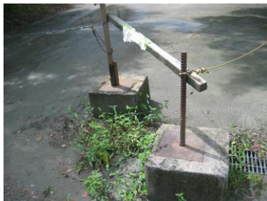
飛び出したアンカー頭部を防護柵として利用
