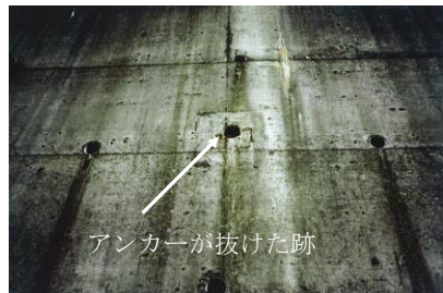
写真 11.1 アンカーが飛び出した跡
