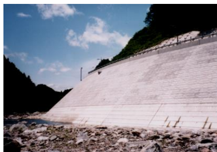
復旧直後の完成写真
