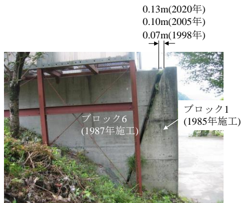
写真 11.3 東側の隅角部の状況
