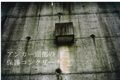
写真 11.1 アンカーが飛び出した跡
