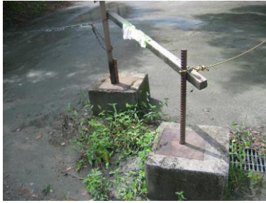
飛び出したアンカー頭部を防護柵として利用
