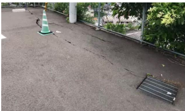
写真 3.3 崩壊の1ヶ月前に撮影された擁壁上部の駐車場
