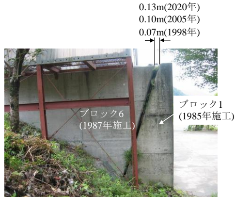
写真 11.3 東側の隅角部の状況
