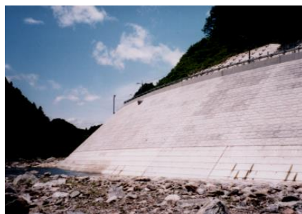
復旧直後の完成写真
