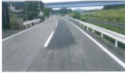
5月25日 路面沈下が発生したためオーバーレイ
