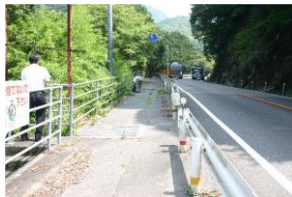
(a) 路面の状況
