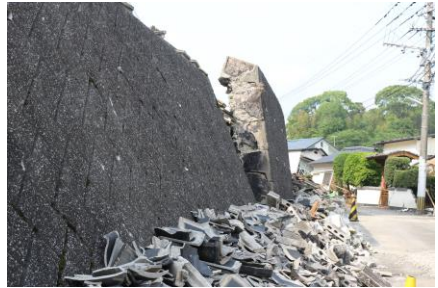
写真 15.3 益城町文化会館の東側宅地擁壁
