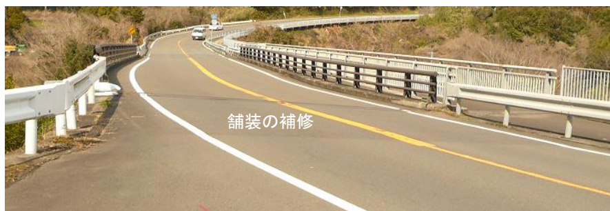
写真 18.2 A2 橋台背後の舗装の補修
