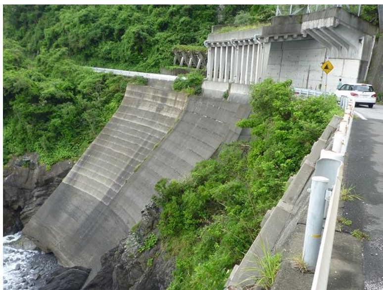
写真 19.2 ロックシェッドと海岸護岸を兼ねた路側擁壁
