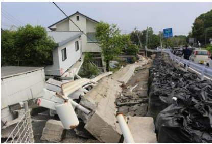
写真 15.2 国道 443 号(益城町)の路側擁壁
