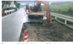
6月28日 再度路面沈下が発生したため、路床部をセメント混合する目的でアスファルト舗装の撤去作業
