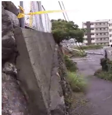
写真 3.2 倒壊した擁壁の端部
