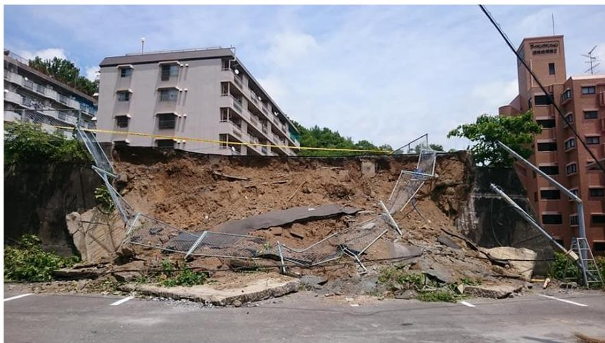
写真 3.1 倒壊したコンクリート擁壁(森伸一郎氏撮影)
