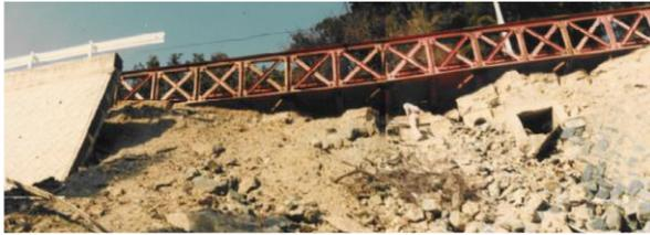
写真 4.1 倒壊したブロック積み擁壁
